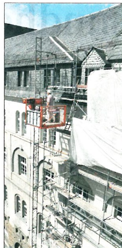
Über einen Lift an der Außenfassade werden Schutt und Baumaterial transportiert. Bis Jahresende wollen die Bauarbeiter in dem Bereich fertig sein.
