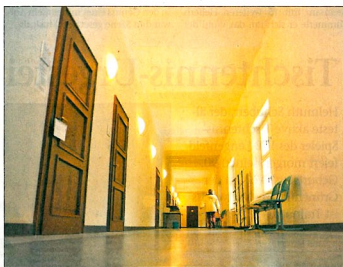
Ein Flur nach erfolgreicher Sanierung.
