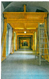
Eine Holzkonstruktion stützt das sanierungsbedürftige Rabitzgewölbe.
