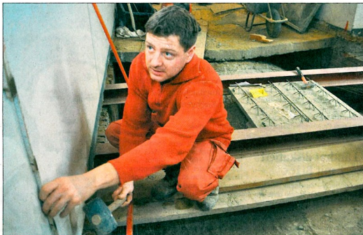
Bauarbeiter Marco Taubert kontrolliert den Einbau eines Stahlträgers. Im Hintergrund ist ein Teil des Fußbodens des Flures im zweiten Obergeschoss zu sehen, der deutlich in der Mitte durchhängt.
