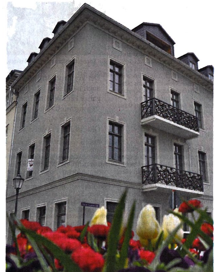
Das sanierte Wohn- und Geschäftshaus Obere Endestraße 1/Altmarkt in Plauen verfügt über sechs moderne Wohnungen und drei Gewerbeeinheiten.
